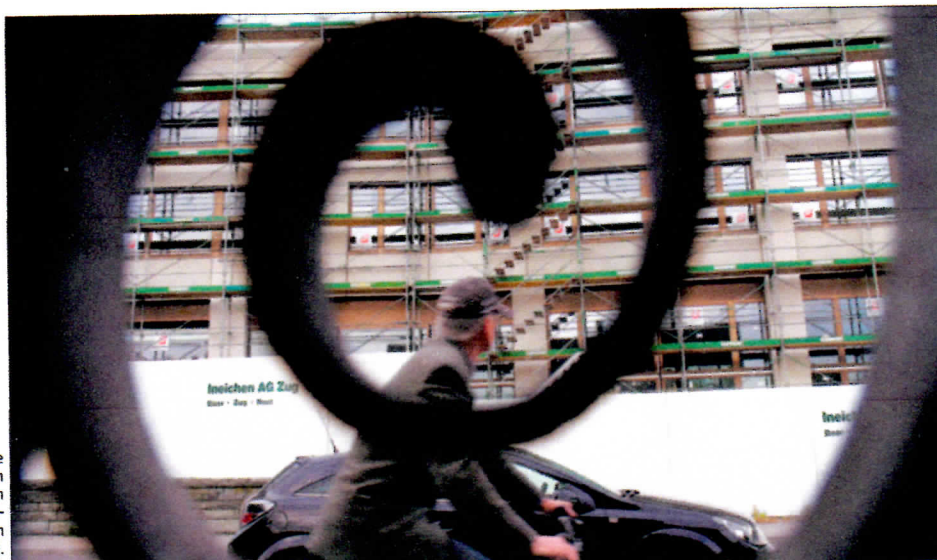
Die Bauarbeiten am neuen Kirchgemeindezentrum laufen planmässig. Bild: Werner Schellbert
